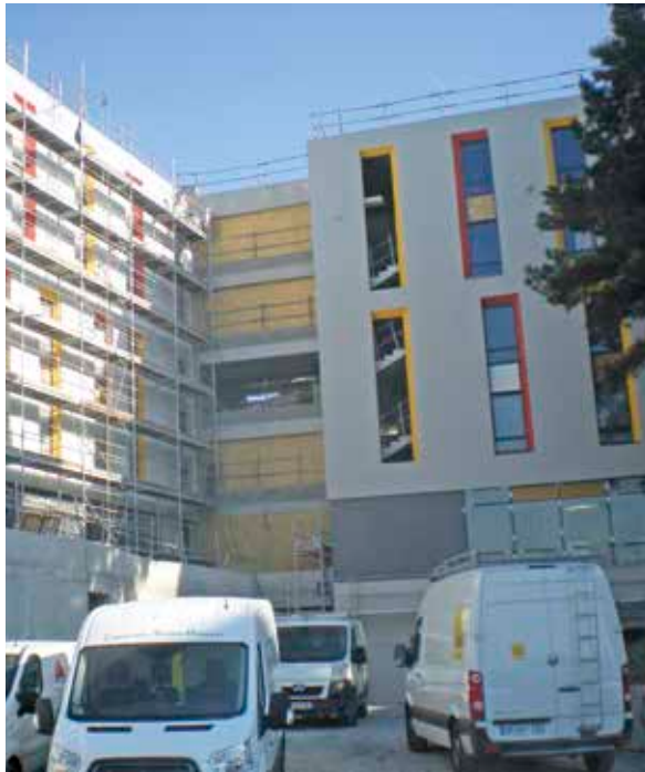
Les travaux avancent pour l'ouverture de l'internat et du nouveau lycée conforme à l'esprit de J. Wresinski.
